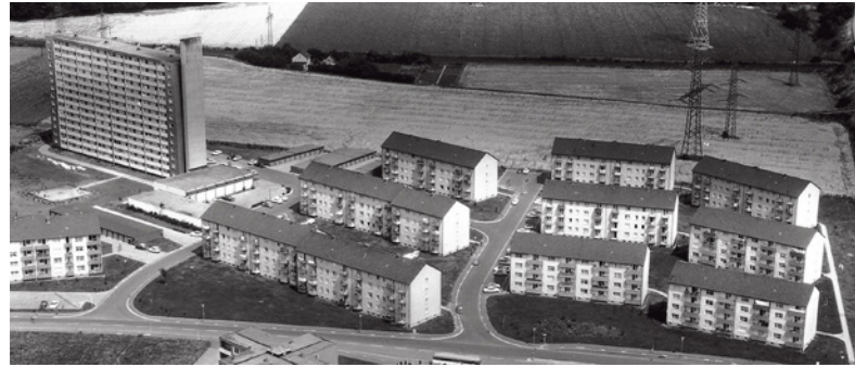
Modellansicht der Wohnsiedlung Rheindorf in Leverkusen nach energetischer Sanierung 2013 und Originalaufnahme aus dem Baujahr 1964
